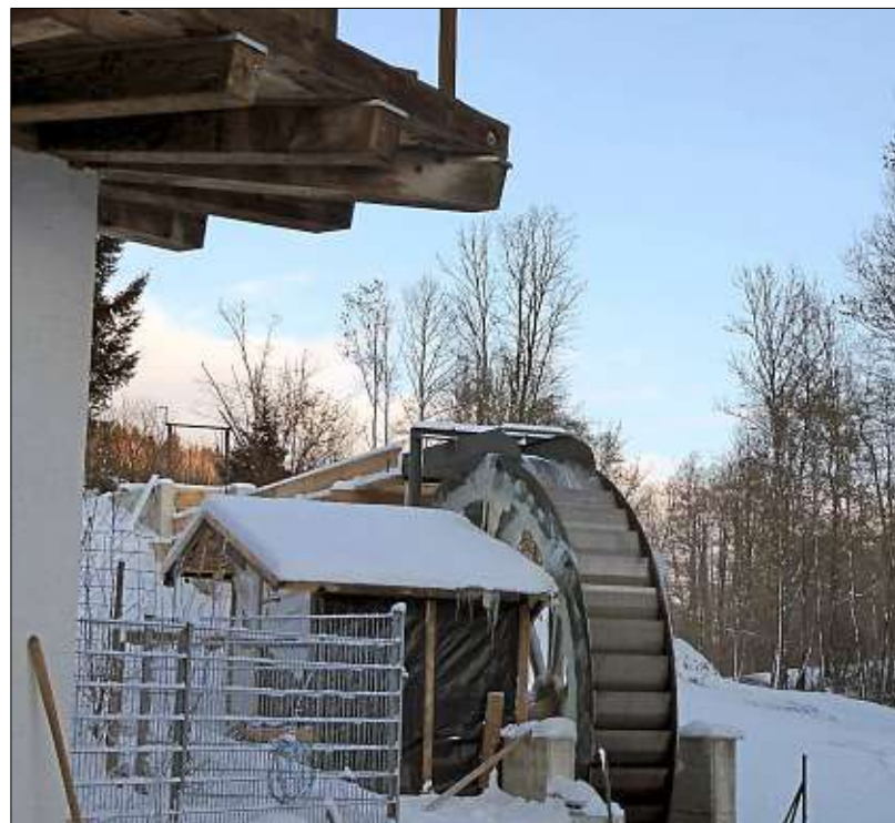
In der Reisachmühle wurde ein altes Wasserkraftwerk modernisiert.
